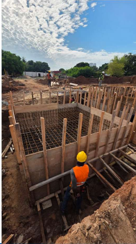
Armado, encofrado y cargamento de cabezales
