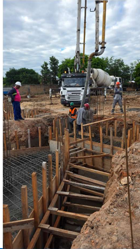
Armado, encofrado y cargamento de cabezales
